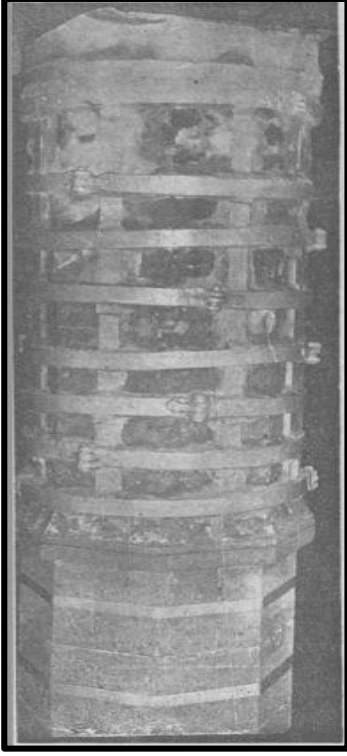
Resim 8: Ulu Camii'nin çatlayan bir sütünü tamir sırasında böyle çemberlenmiştir.
