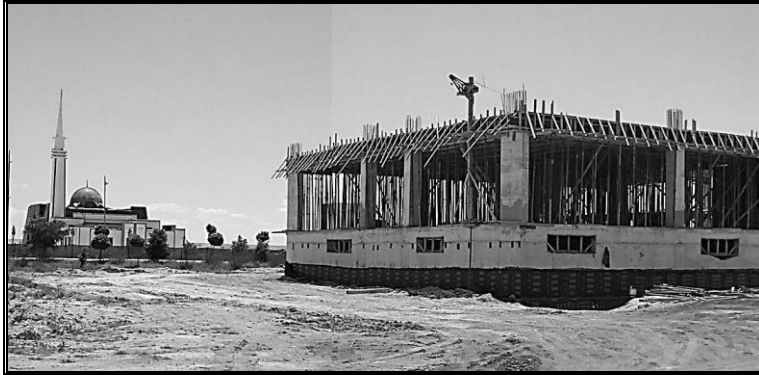
Fakülte binamızın inşaatı. 17.06.2014
