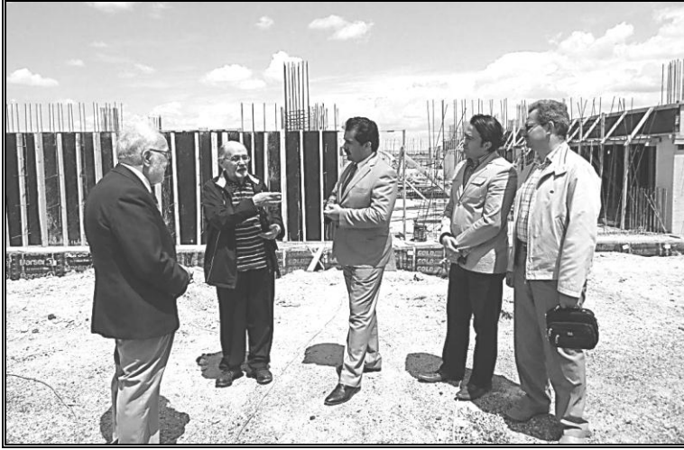
Fakülte binamızın inşaatı. 20.05.2014 17
